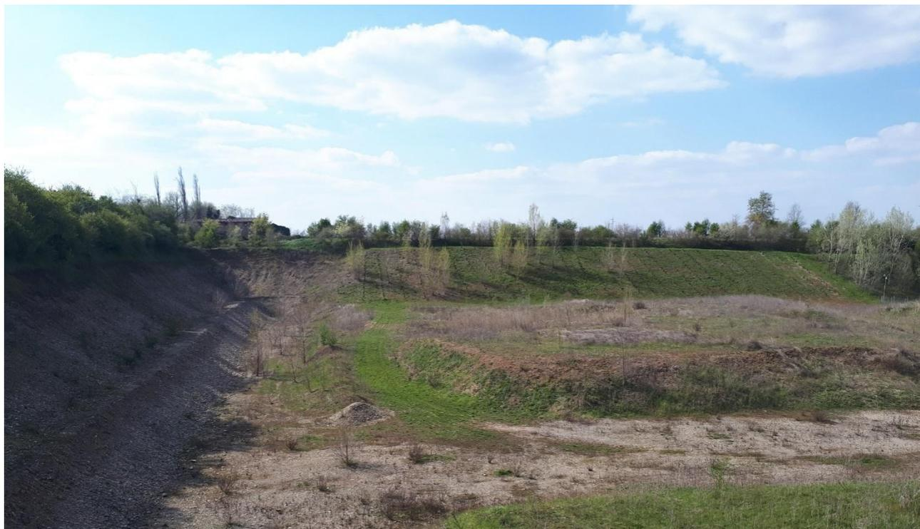
*Figura 7: Cava Gazzuoli-Fo – ex lotti 7a-b-c; ripresa fotografica del fronte ovest nell'anno 2020; il fronte ovest del lotto 7a risulta già interamente sistemato; sotto al terrapieno perimetrale rivegetato sono visibili, sulla scarpata rinfiancata a 27°, gli impianti vegetazionali di nuovo impianto oltre ad alcuni esemplari arborei già sviluppatisi spontaneamente e preservati.*
